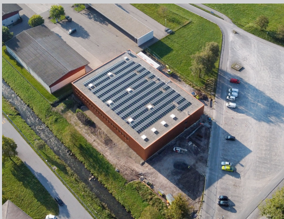
Parkplatz direkt vor der Halle
